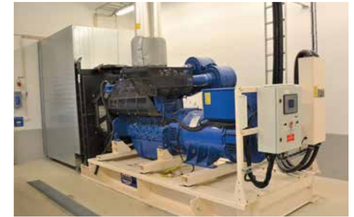
Nødstrømsagregat for beredskap.
